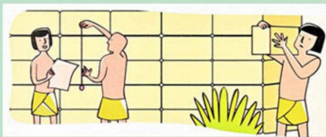
a) all'epoca già si conosceva l'uso del filo a piombo - metodo ancor oggi in uso. Esso consiste nel fissare, all'estremità di un filo, un piccolo cuneo di piombo, mentre l'estremità libera del filo viene appesa in un punto del muro in costruzione; la tecnica assicura la perpendicolarità delle pareti.
